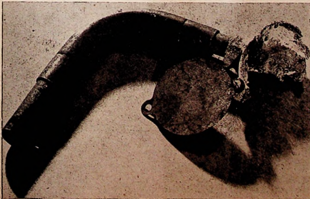
Foto 1. Het „corpus delicti”: de lasdoos, met een deel der buisleiding.
